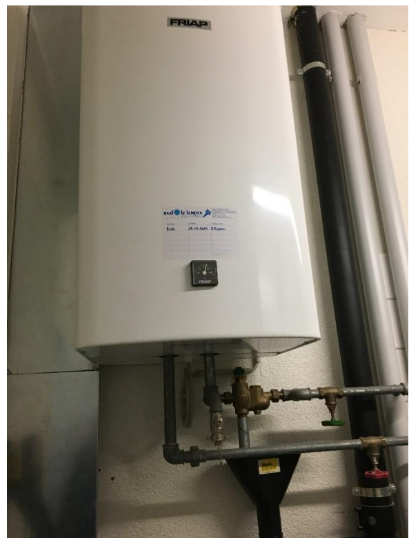
Bild 25: Wasssererwärmer dezentral in einem Putzraum
