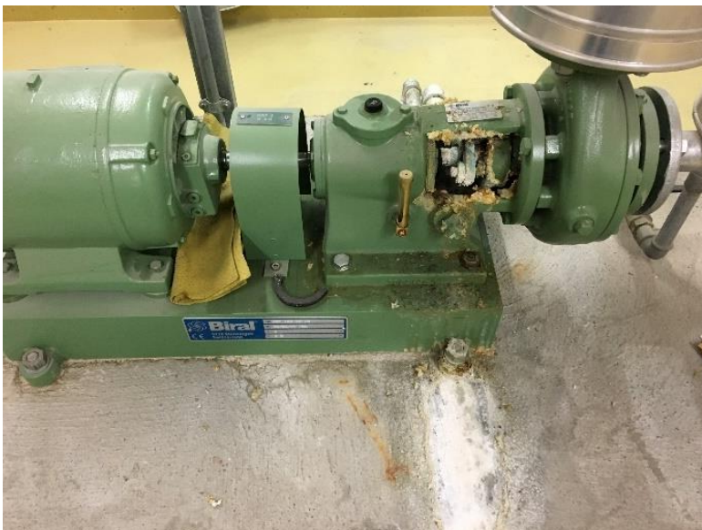
Bild 13: Rinnende Warmwassermwälzpumpe
