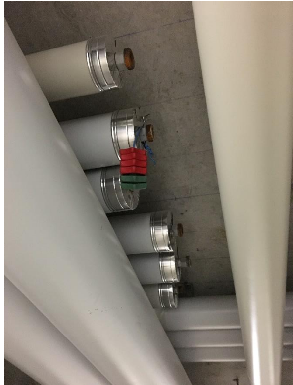
Bild 19: Abgehängte Leitungen nicht mehr gebrauchter Apparate
