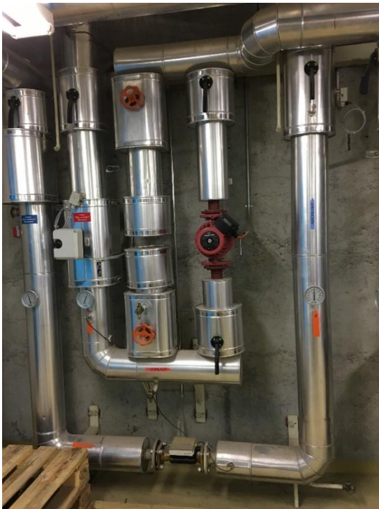
Bild 5: Heizungsseitige Brauchwarmwassergruppe
