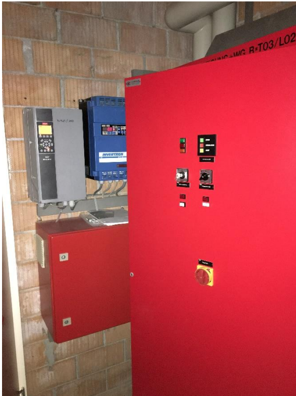
Bild 22: Alter Lüftungsschaltchank
