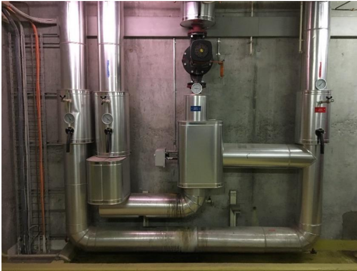
Bild 4: Hochhaltung Ölkessel mit Flecken bei Feldgeräten
