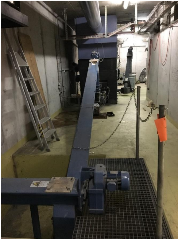
Bild 2: Förderschnecke mit Holzkessel
