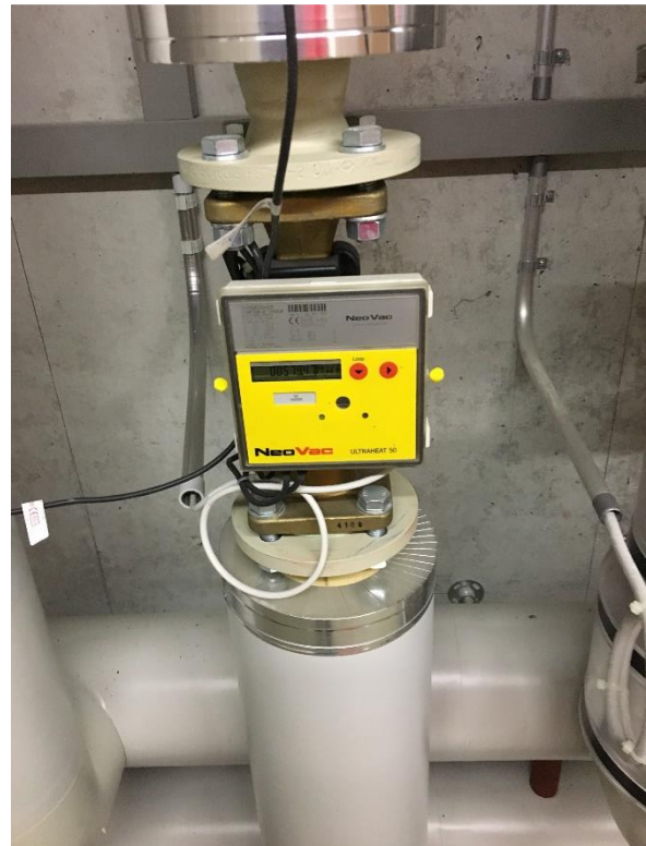
Bild 21: Wärmezähler einer Unterstation
