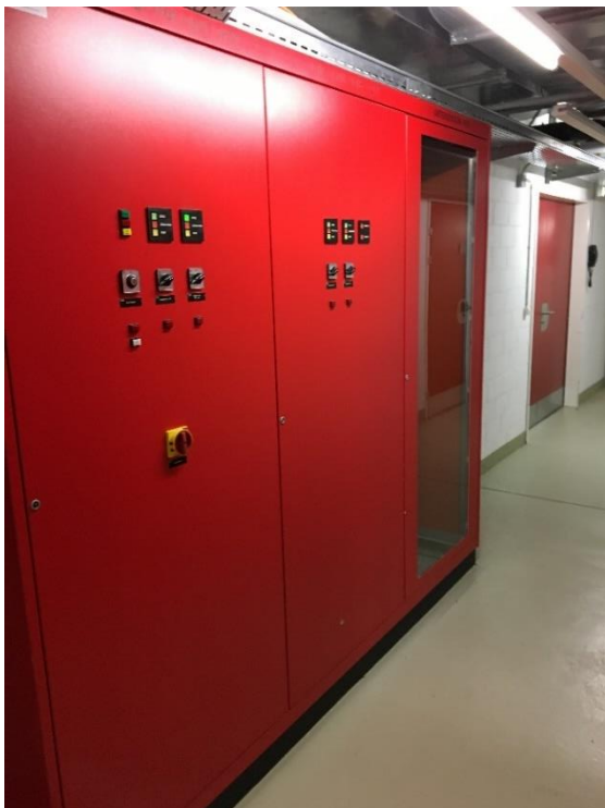
Bild 7: Schaltschrank der drei Lüftungsanlagen
