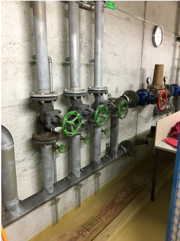
Bild 12: Überdimensionierte Verteilbatterie
