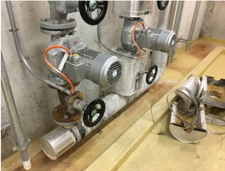
Bild 14: Rinnende Zirkulationsverteilung mit verrosteten Schiebern
