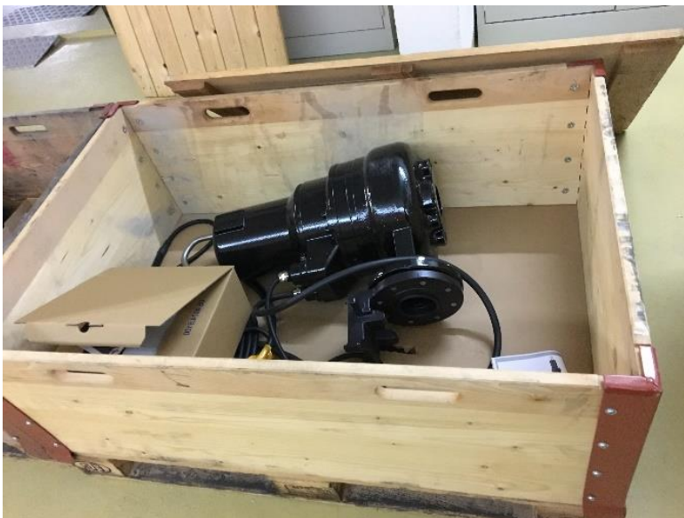
Bild 15: Vorbereitete Fäkalpumpe für Auswechslung
