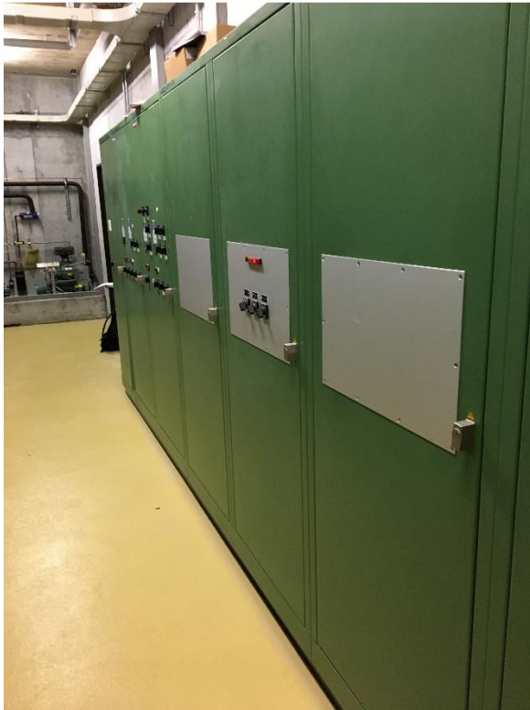
Bild 8: Schaltschrank der Lüftungs- und gewerblichen Kälte-Anlagen
